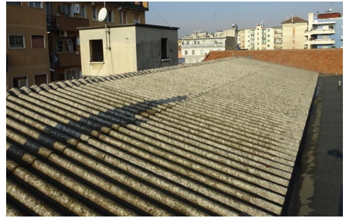
Vecchia copertura in cemento-amianto (Eternit)
