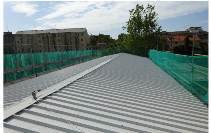
Nuova copertura in pannelli di alluminio coibentato e nuova "linea vita"
