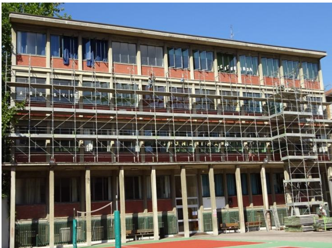
Fase di allestimento ponteggio sulla facciata principale della Casa della Gioventù
